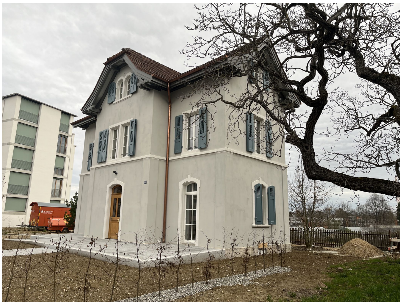
Zollhaus März 2023 (kurz vor Fertigstellung)
